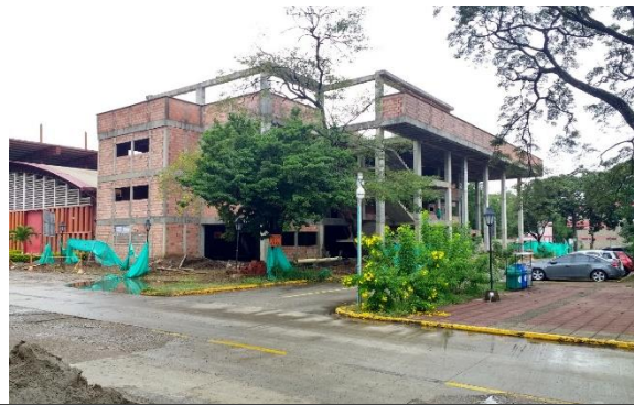
Avance de Obra – Construcción de estructura en concreto y mampostería del Edificio de Bienestar Universitario.
