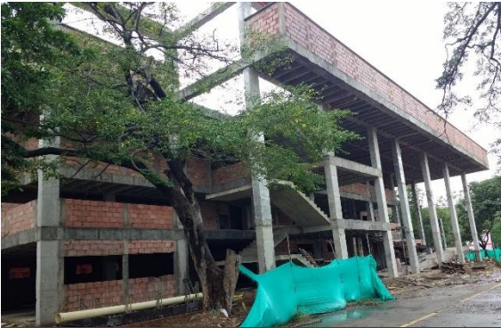
Avance de Obra – Construcción de estructura en concreto y mampostería del Edificio de Bienestar Universitario.
